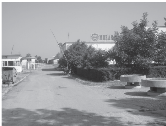
Објекти фабрике машина „Морава“ која не послује, у делу објекта послује ЈП „Топлификација“ Пожаревац
