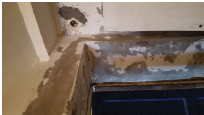
оштећења зидова и плафона настала дејством влаге (подрум)
