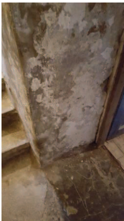
оштећења зидова и плафона настала дејством влаге (подрум)
