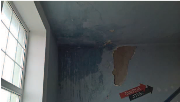
оштећења зидова и плафона настала дејством влаге (спрат)
