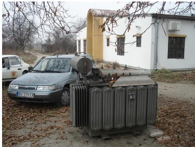
Osoblju prisutnom u upravnoj zgradi izvorišta je usmenim putem nagovešten mogući štetni uticaj usled isticanja trafo ulja u zemljište i ukazano na potrebu uklanjanja i adekvatnog zbrinjavanja trafoa, kao i utvrđivanja porekla ulja (piralensko ili drugo).
