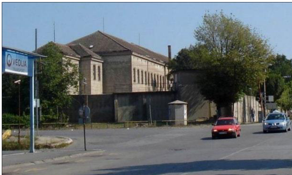
Slika 3 - Postojeći smeštajni objekat (br.1) koji je planiran za rušenje
